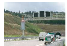
VKS Anlage Rennsteig
